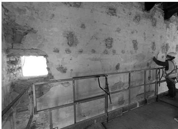
Vestíbulo general. Eliminación de morteros de ce- mento y selección de estratos a restaurar
