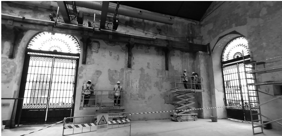
Fundición: Aspecto de un parámetro intervenido
