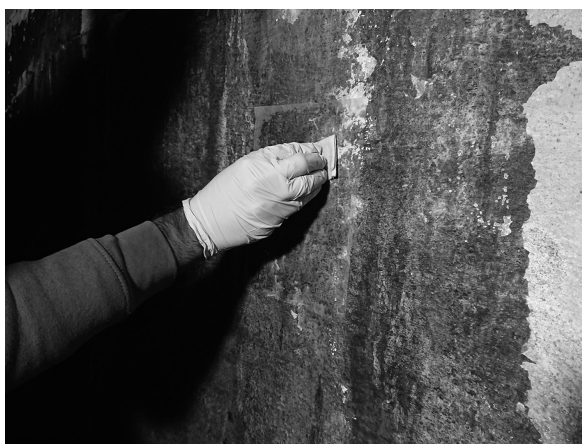
Sala de crisoles. Fijación de las capas de cal en- negrecida
