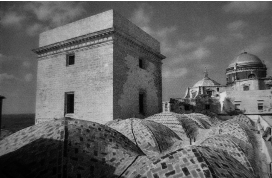
Fig. 4. Torreón del Sagrario desde la cubierta de la Catedral Vieja.
