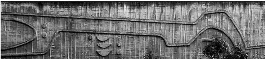
(Fig.5 Mural de hormigón de la fachada lateral.
