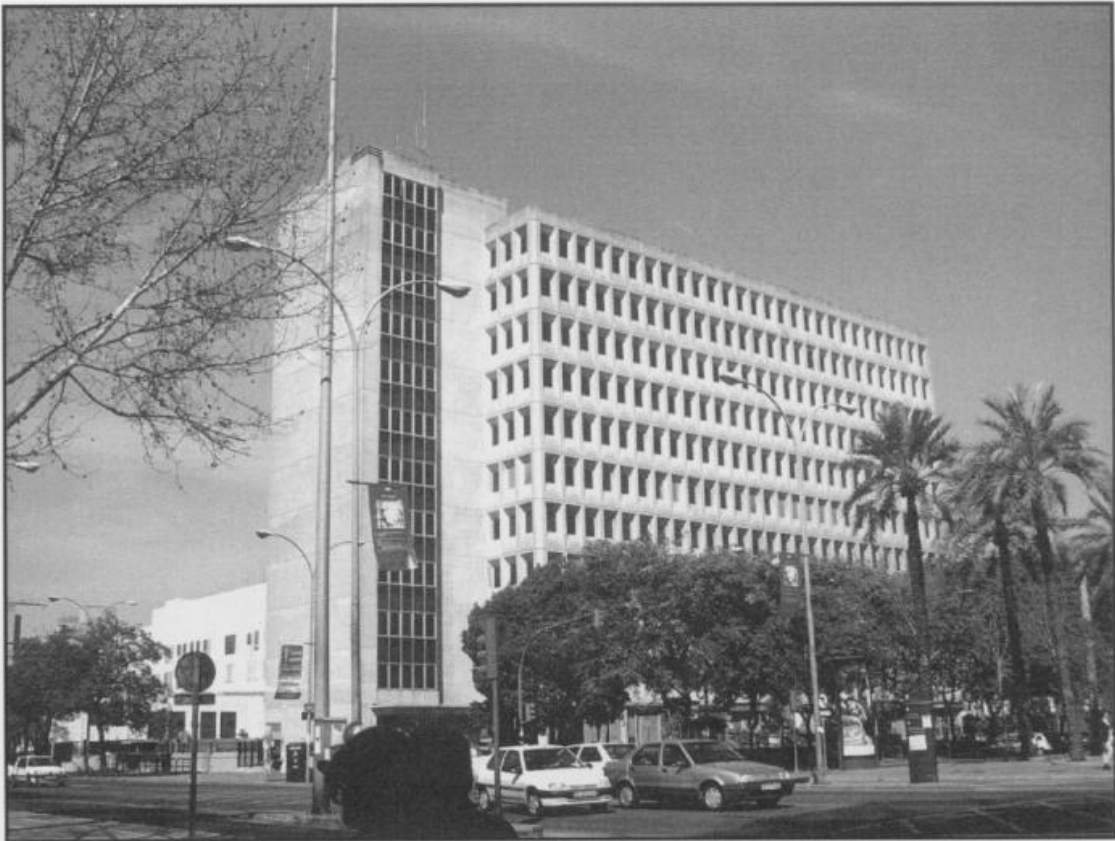
6. Edificio "Sevilla 1" Avda. San Francisco Javier Luis Fernando Gómez-Stern y Manuel Trillo de Leyva (1972)
