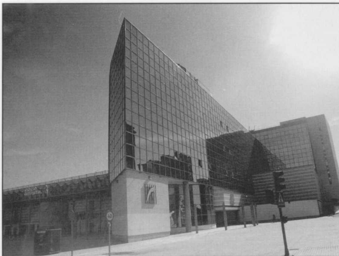
7. Edificio "Alcampo" Avda. del Tamarguillo, n° 29 José Moreno Vález (1991)
