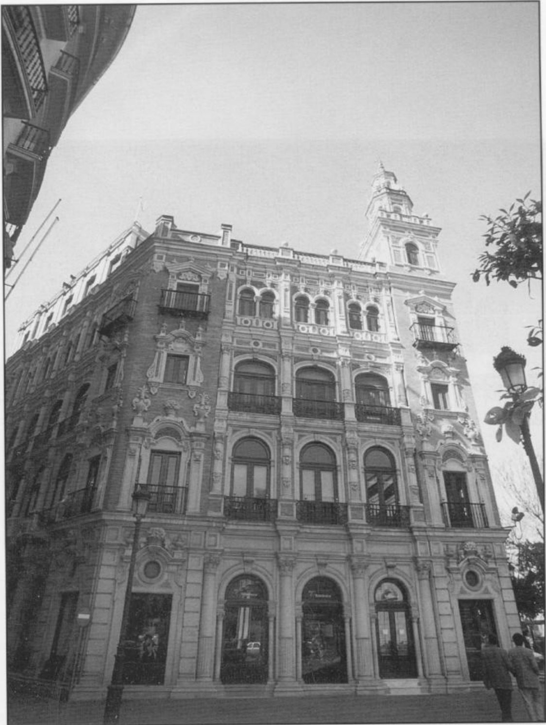
2. Edificio de la Compañía Telefónica Plaza Nueva, nº2 Juan Talavera Heredia (1928)
